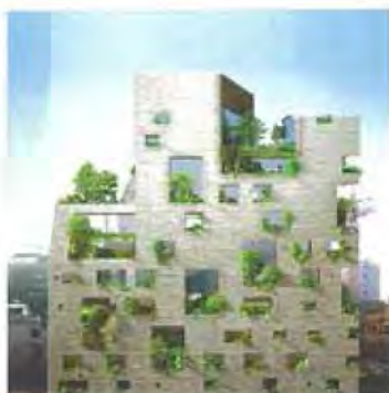
▲ ► Stone Garden, immeuble mixte à Beyrouth. Liban, en chantier, Lina Ghotmeh - architecte © Lina Ghotmeh Architecture
